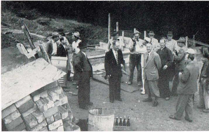
Bau der Fundamente der Halle
